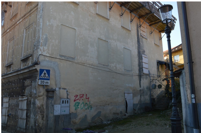
Slika 26: Severna fasada; luščenje ometov.
