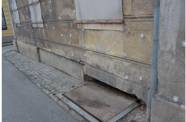
Slika 21,22: Kamnit cokel na južni in čelni fasadi, ki je razpokan in vidni znaki prekomernega navlaževanja zidu ter odpadle kamnite plošče cokla.
