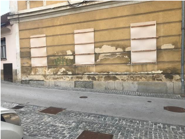
Slika 21,22: Kamnit cokel na južni in čelni fasadi, ki je razpokan in vidni znaki prekomernega navlaževanja zidu ter odpadle kamnite plošče cokla.
