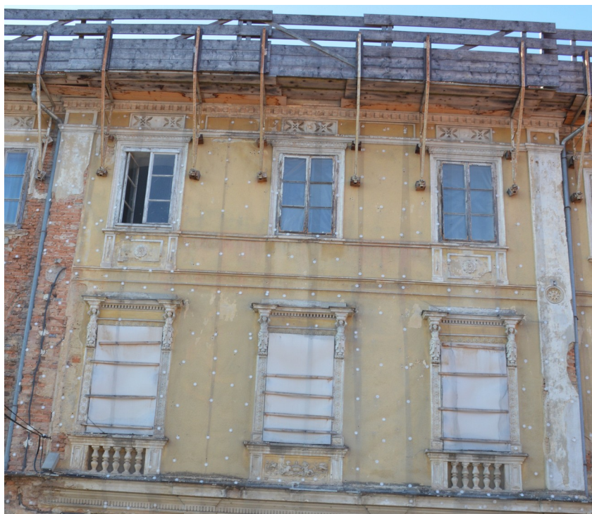
Slika 25: Historična čelna fasada s poškodovanimi klasičnimi dekorativnimi elementi (balustri, reliefi, kariatide...); okrasje oken v drugem nadstropju je enostavnejše in se konča v kapnem vencu (simsu) z reliefnim trakom.
